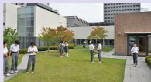
いこいのスペース 屋上庭園
